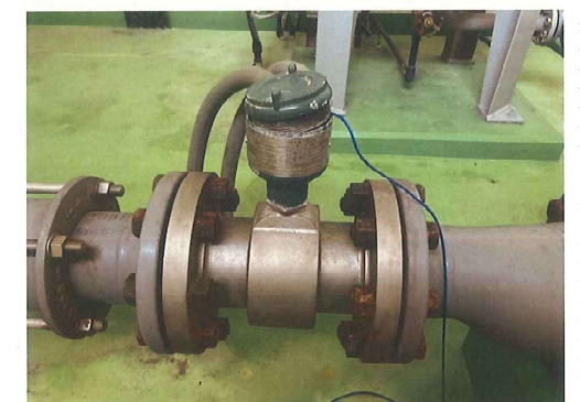
小白浜ポンプ場 流量計 流量計検出器
